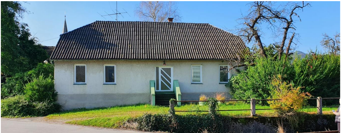
Slika 3: Stanovanjski objekt, pogled s Hermanove ceste
